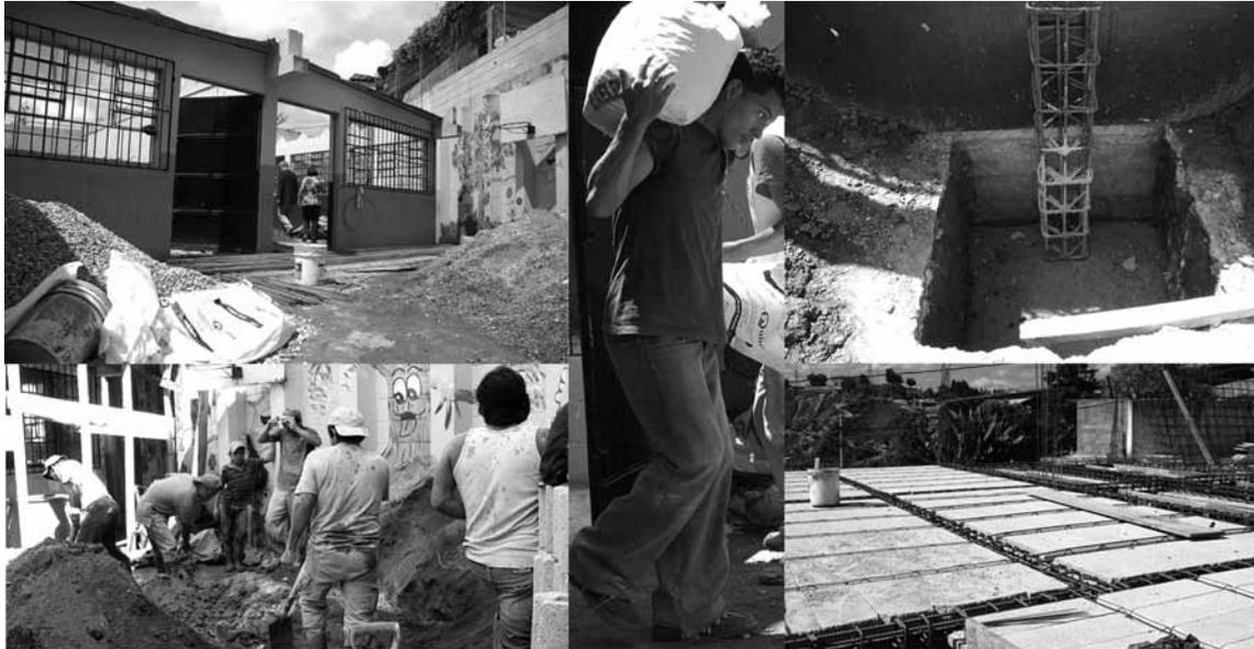
In den letzten beiden Wochen wurde der Boden, der die zweite Etage trägt, mit Betonbalken und Formsteinen gefertigt und mit einer Betonschicht übergossen. Die neun eingezogenen Stützpfiler, die durch die erste Etage geführt wurden, werden nun in der zweiten Etage weitergeführt.
